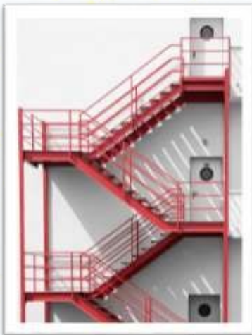
Наружная открытая эвакуационная лестница
