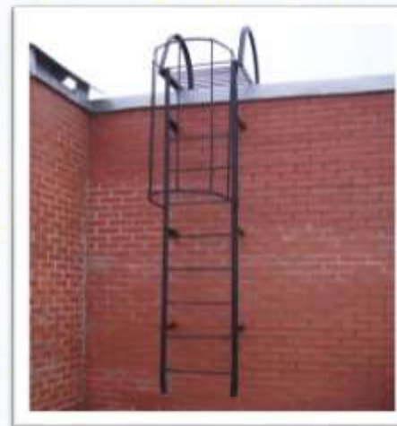
Наружная пожарная лестница
